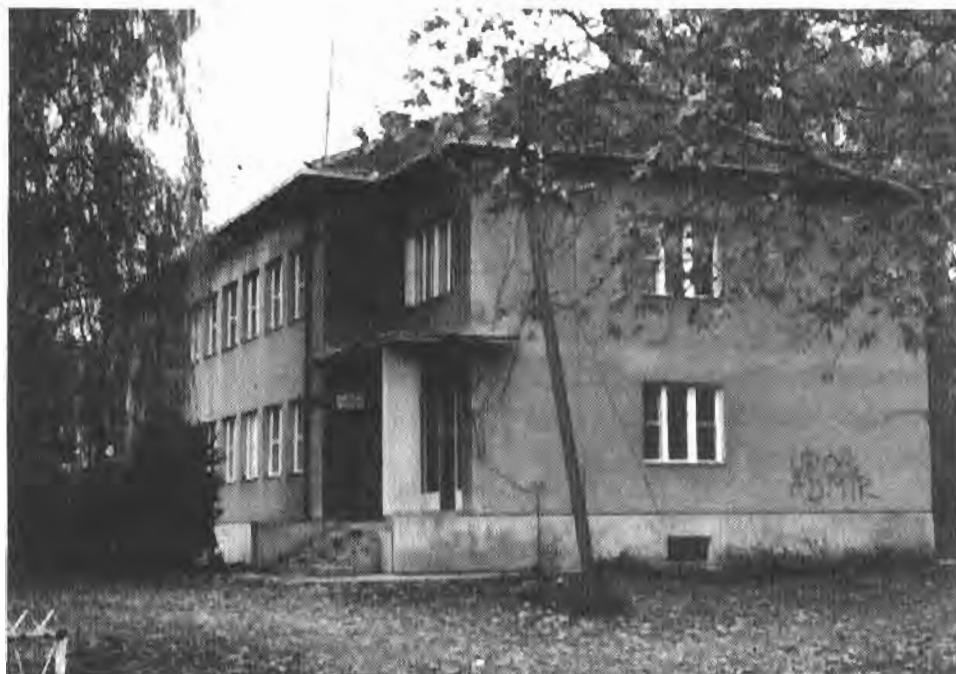
Zgrada zavoda za voćarstvo u Bijelom Polju
